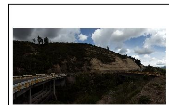
RIESGO MODERADO PUENTE SOBRE QUEBRADA EL ROSARIO
