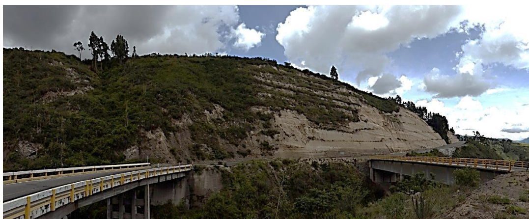
Gráfico 17. Riesgo Moderado km 58+000, Puente sobre quebrada El Rosario
