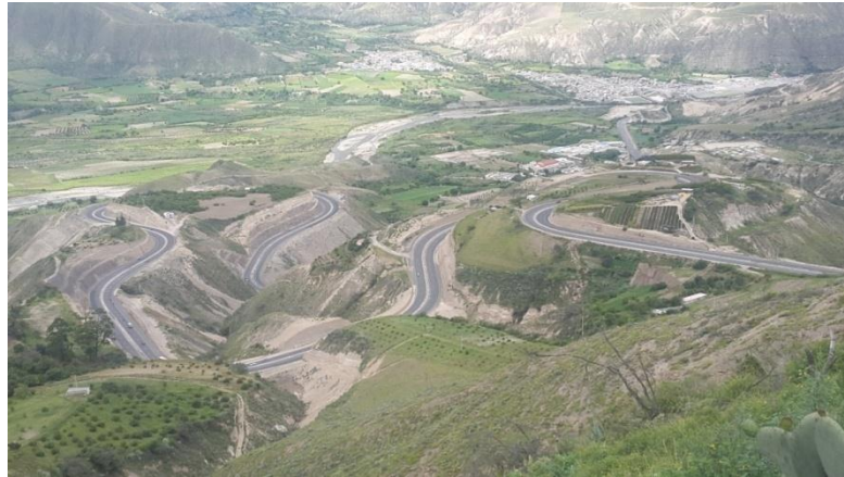
Fotografía 1: Ampliación Vial – Vista desde km 48+000
