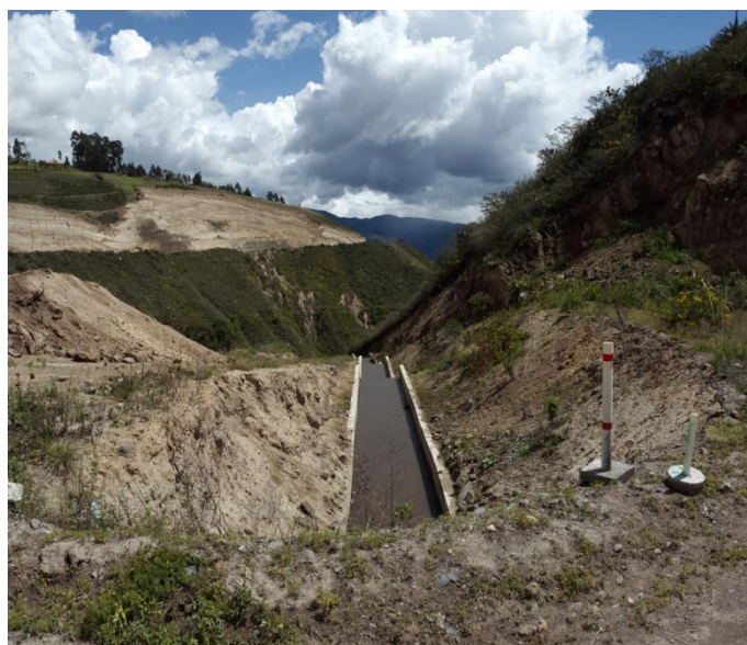
Fotografía 8: Infraestructura Crítica, Canal de Riego Monte Olivo.
