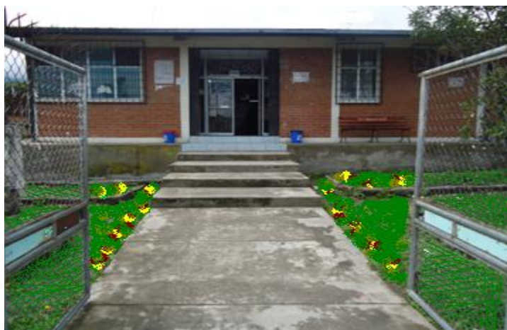
Figura Nº 3 Sub Centro de Salud de San Antonio de Ibarra
