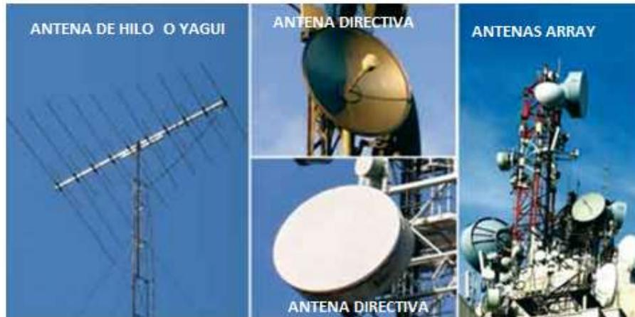
**Figura 10.** Tipos de antenas de Telecomunicaciones
