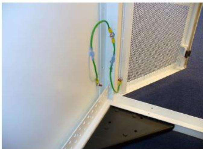
Figura 140. Ilustración de una conexión de unión de un gabinete a la puerta del armario
