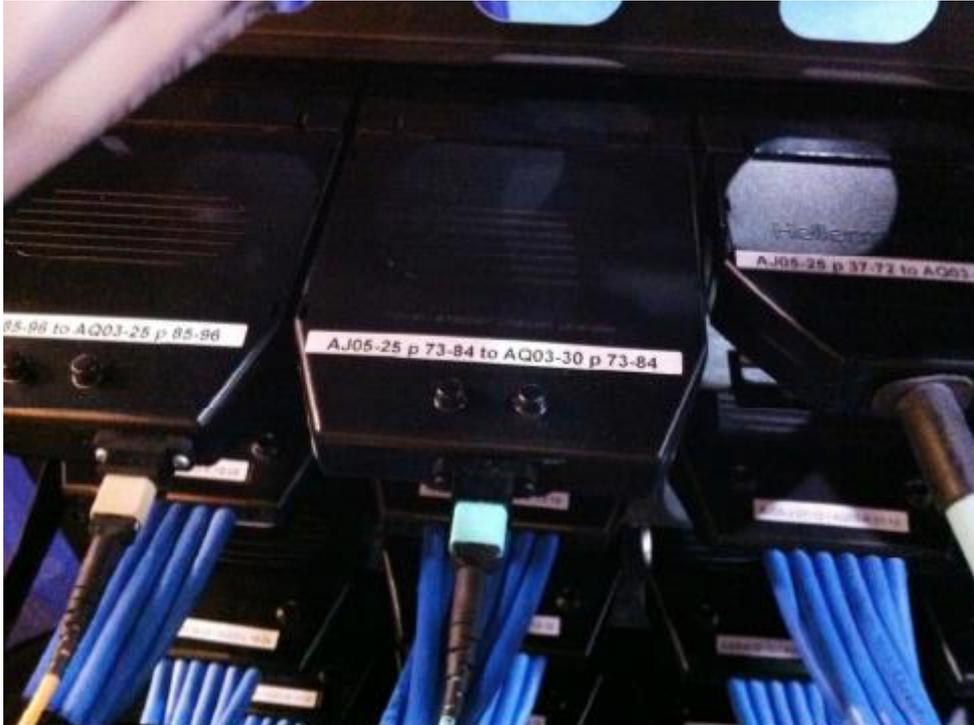
Figura 64. Ejemplo de etiquetado cassette pre terminado
