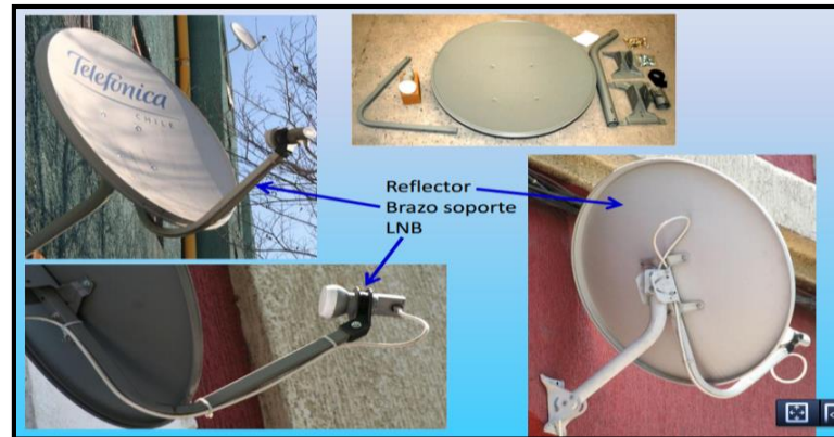
FIGURA 5.- Componentes de la antena parabólica.
