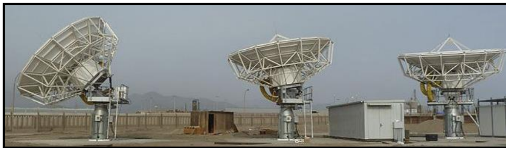
FIGURA 10.- Estación terrena de Lurín- Lima-Perú
