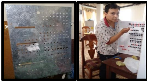
Fig.10. Montaje circuito de control
