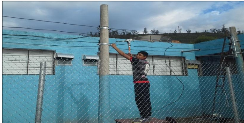
Figura 53: Templado de conductores
