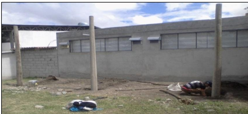
Figura 48: Izado de postes de hormigón
