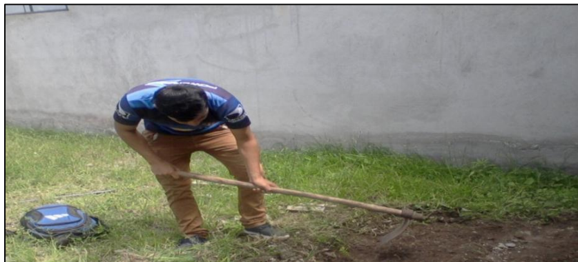
Figura 114: Limpieza de espacio físico para implementación de la red
