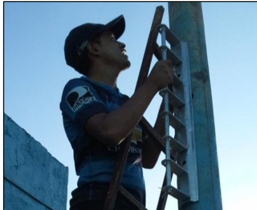
Figura 51: Instalación de Racks
