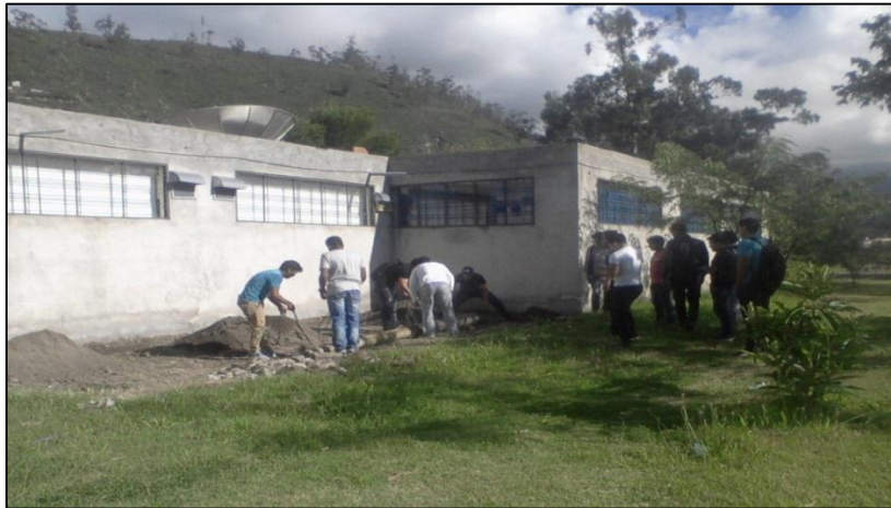
Figura 117: Instalación de postes de hormigón
