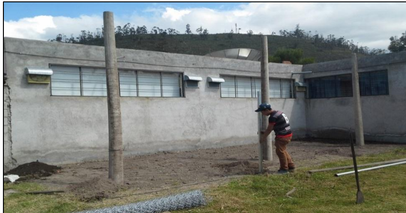
Figura 49: Cerramiento de área para red de distribución
