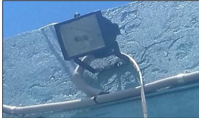
Figura 57: Instalación de reflectores
