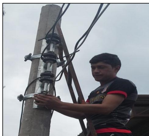
Figura 52: Instalación de aisladores
