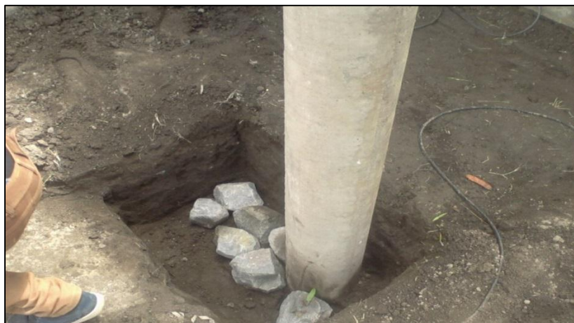
Figura 118: Compactación del piso para la instalación de postes de hormigón
