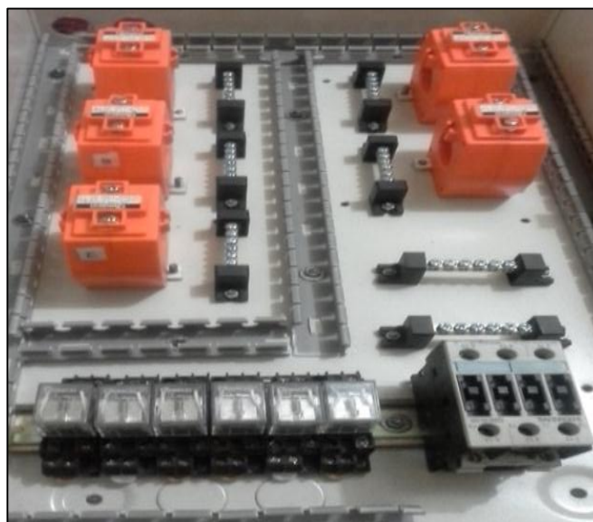
Figura 56: Instalación de elementos del módulo de control y fuerza
