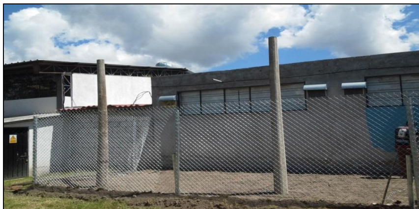
Figura 121: Vista de finalización de cerramiento
