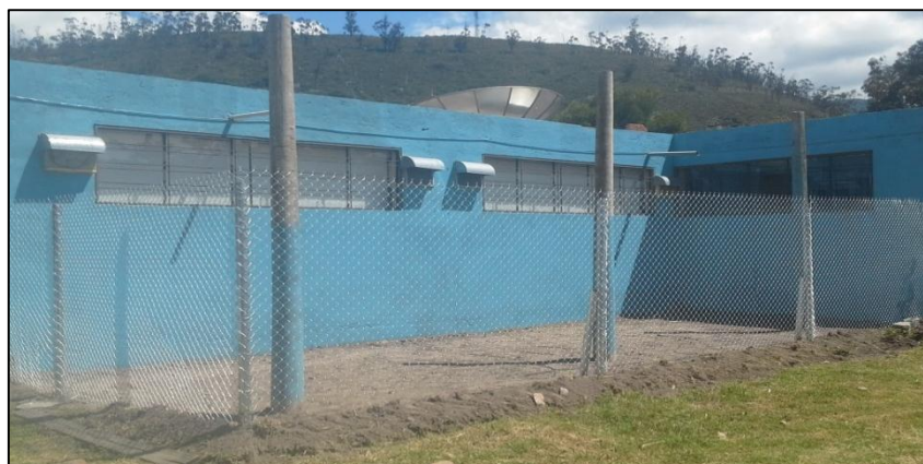
Figura 50: Fachada del lugar de instalación de tableros
