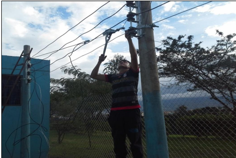
Figura 126. Instalación de las líneas de alimentación
