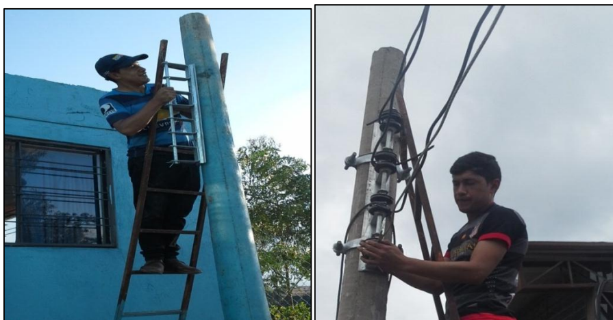
Figura 124: Instalación de Racks
