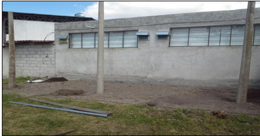
Figura 119: Vista de la instalación completa de postes de hormigón
