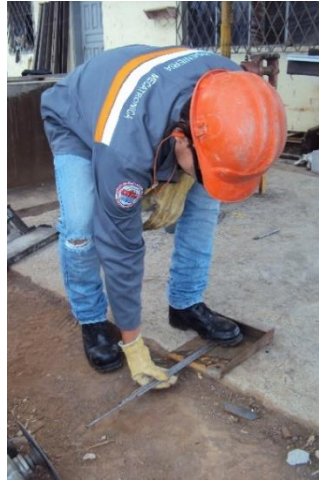
Figura 1.2 Paso 2 para el corte, sujetar las varillas
