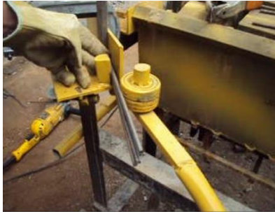
Figura 1 .4 Paso 1 para el doblado, alineamiento de las varillas
