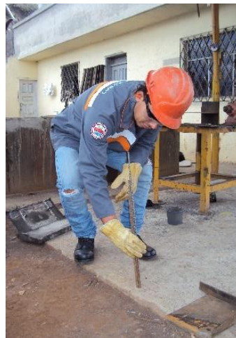
Figura 1.1 Paso 1 para el corte, alineamiento de las varillas
