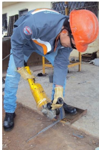
Figura 1.3 Paso 3 para el corte, cortar las varillas utilizando amoladora
