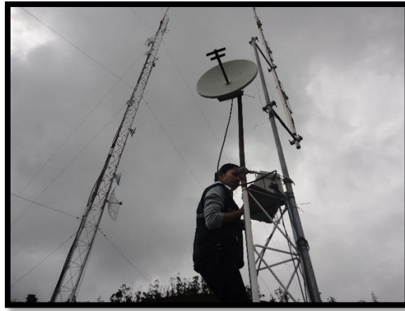
Figura 76. Ubicación inicial de la antena receptora del enlace microondas en dirección oeste
