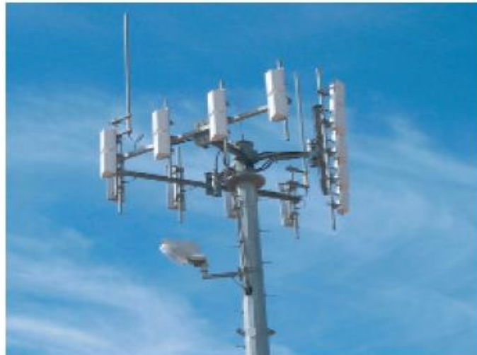
Figura 17: Ejemplo de antena sectorial en tres sectores y cada sector con 120^\circ
