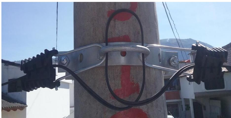
Figura 27. Colocación de las vinchas en el poste para sujetar a la fibra.
