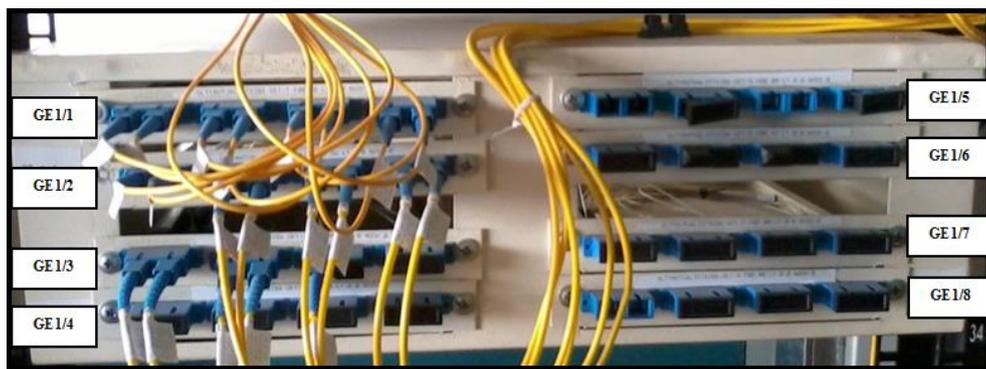
Figura 52. Distribución de los puertos Giga en el Odf de 64 puertos.
