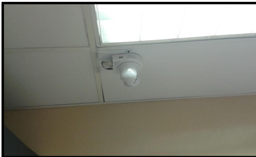
Imagen 22.-Cámaras de seguridad colocadas en el techo falso Referencia: Datacenter del GAD Provincial de Imbabura, 2015.
