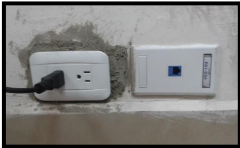
Imagen 13. Instalación puntos de red
