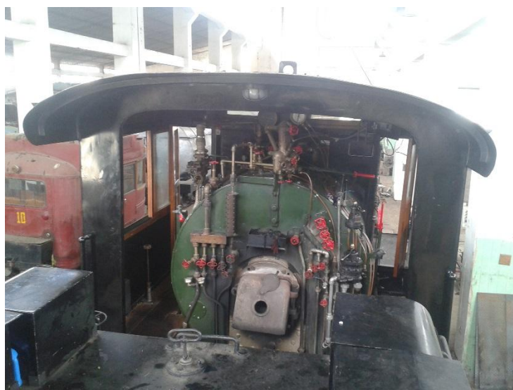
Figura 2: Sistema de tuberías y caldera
