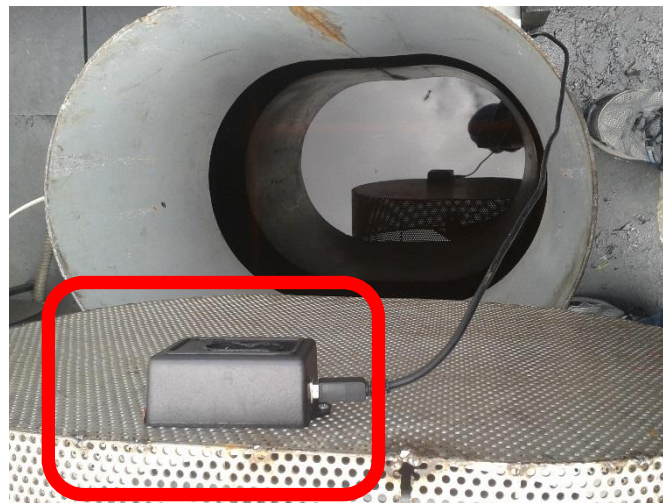
Figura 62. Instalación del sistema de sondeo del nivel de agua
