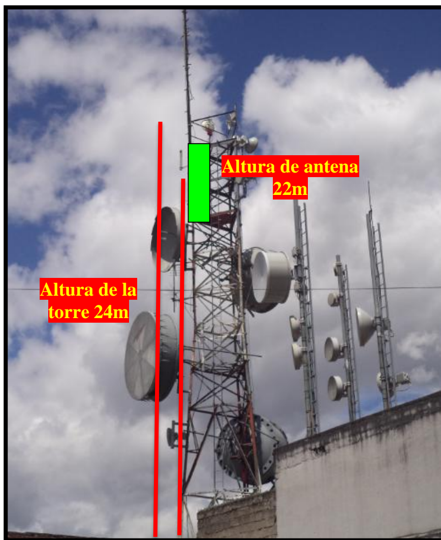
Figura 34 Altura de antena en estación San Juan Fuente: Elaborado por autor
