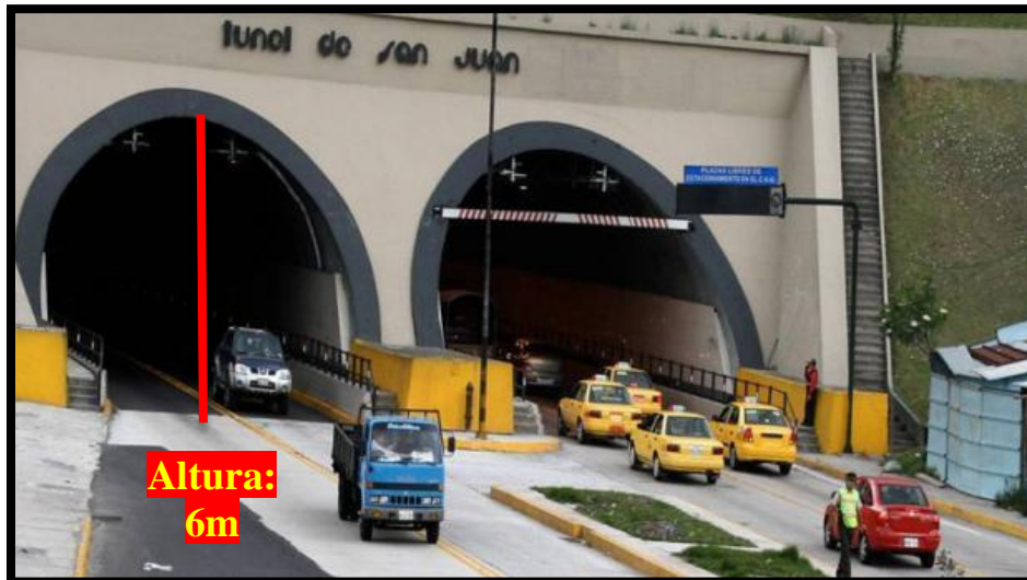
Figura 32 Altura túneles de San Juan Fuente: Elaborado por autor
