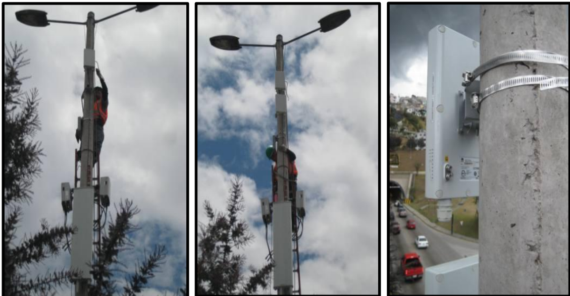
Figura 67 Instalación de los RRN3301 LTE/3G y el apuntamiento hacia la Estación San Juan (Azimut: 200°) Fuente: Elaborado por autor
