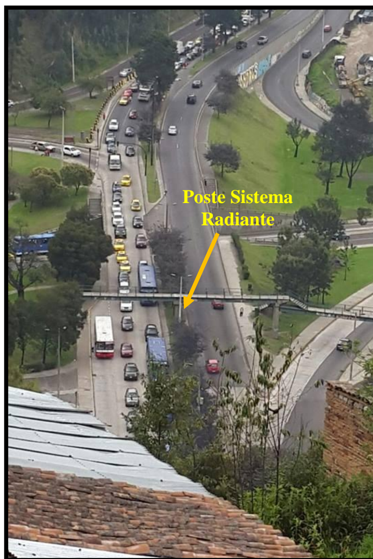
Figura 35 Línea de vista directa desde la Antena de la estación San Juan hasta la RRN ubicada en el poste del sistema radiante.
