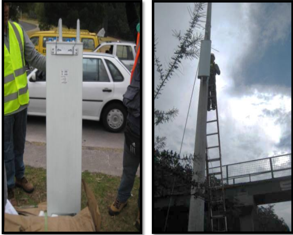
Figura 64 Instalación Antena Panel Dual Modelo ADU461819 Fuente: Elaborado por autor
