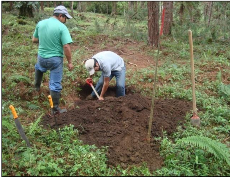
Ilustración C11. Construcción de calicata
