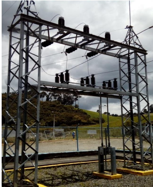
Figura 48 Seccionamientos del transformador
