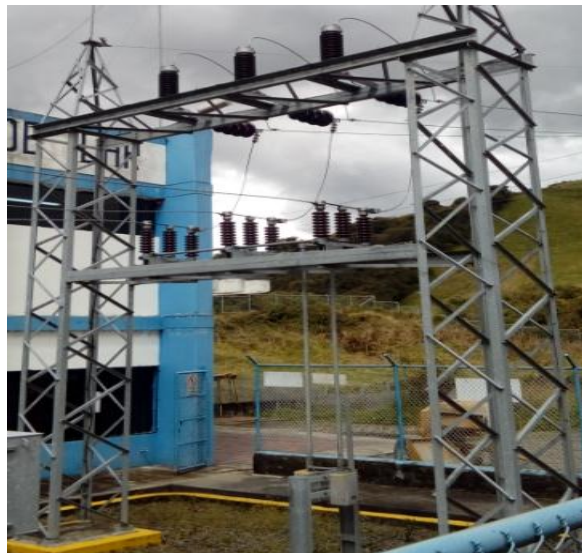
Figura 30 Seccionamiento de apertura y aterrado
