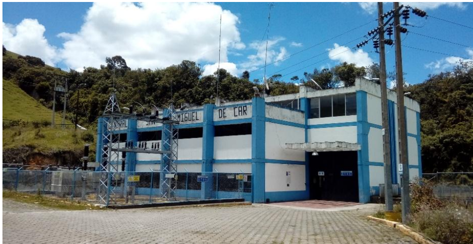
Figura 19 Vista principal de la central hidroeléctrica San Miguel de Car
