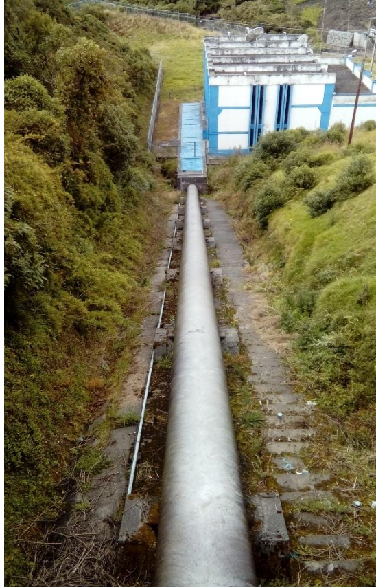
Figura 37 Vista de la tubería de presión
