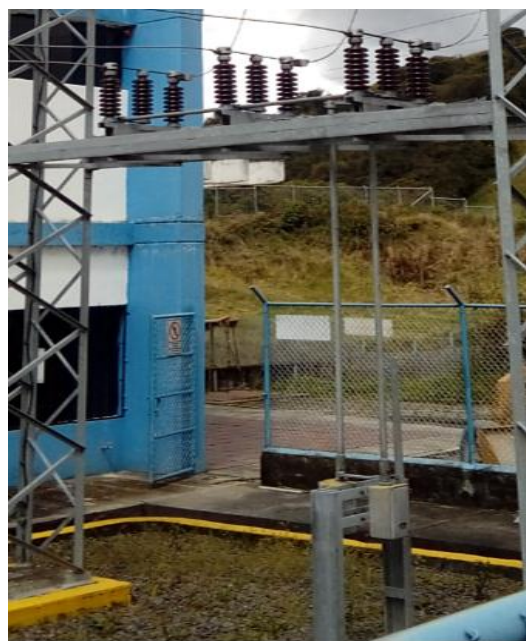
Figura 50 Seccionamientos con puesta a tierra
