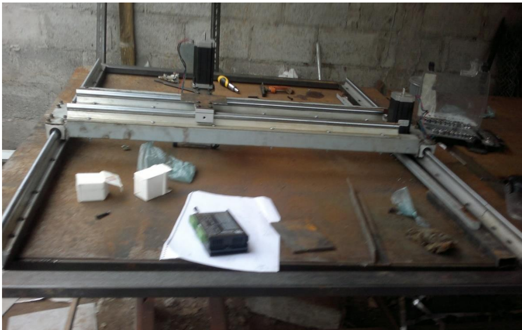
Figura 5.3 Montaje del sistema de transmisión
