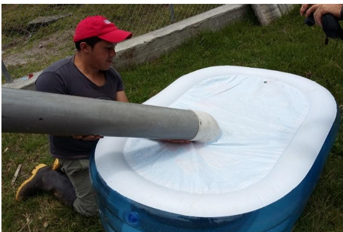
Fotografía 13: Instalación del dispositivo para captura de gas
