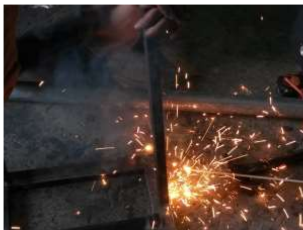
Figura 5.3: Soldadura del brazo inferior.
