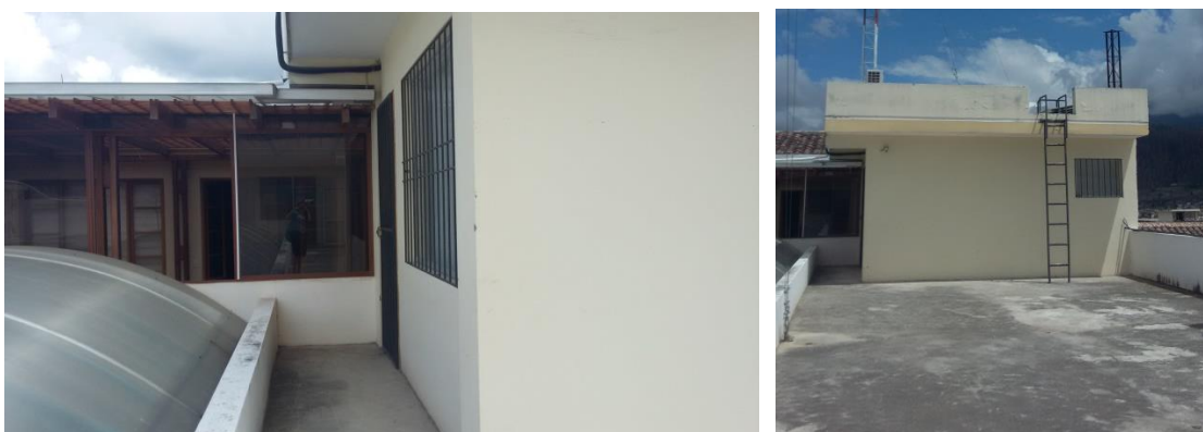
Figura 42 Ubicación del cuarto de comunicaciones de la terraza. Fuente: Instalaciones GADMO
