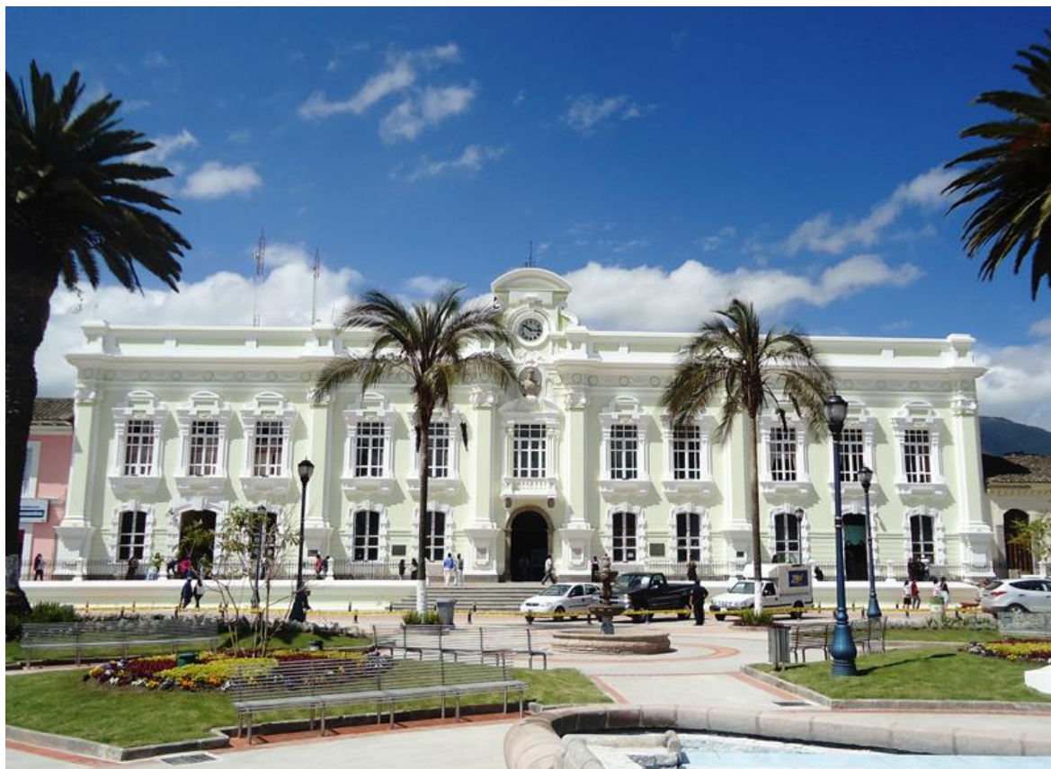
Figura 21 Edificio del GADMO Fuente: ( GAD Municipal del Cantón Otavalo, 2015)
