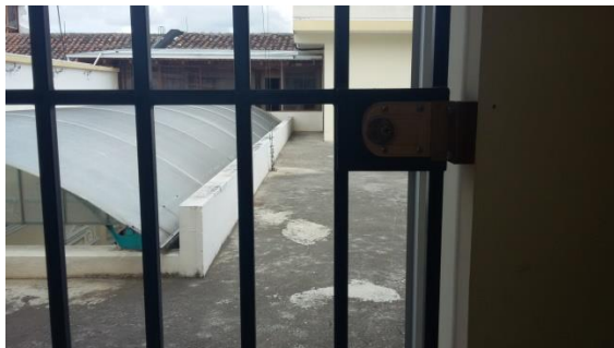
Figura 33 Puerta de acceso a la terraza del GADMO. Fuente: Instalaciones GADMO
