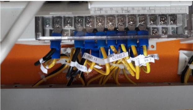
*Figura 26 Etiquetado del PLC.*
