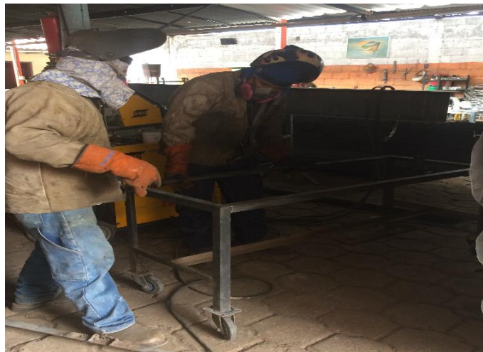
Figura 51: Construcción de la estructura.
