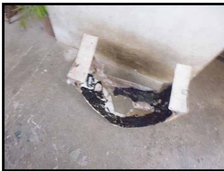
FIGURA 37: Remachado las láminas de plástico contra las piezas de gel coat.
