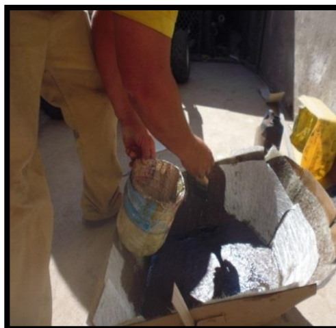
FIGURA 34: Colocación de fibra de vidrio en los moldes
