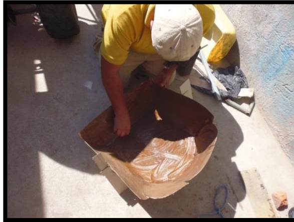
FIGURA 33: Recubrimiento con cera desmoldante
