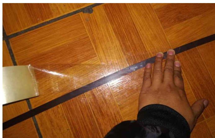
Figura 75. Proceso de instalación de la cinta magnética
