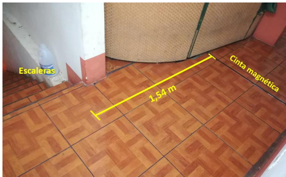
Figura 67. Cinta magnética instalada a 1,54m de las escaleras
