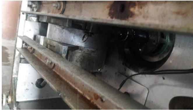
Figura 42. Motor (transmisión de movimiento) antes de la reconstrucción.
