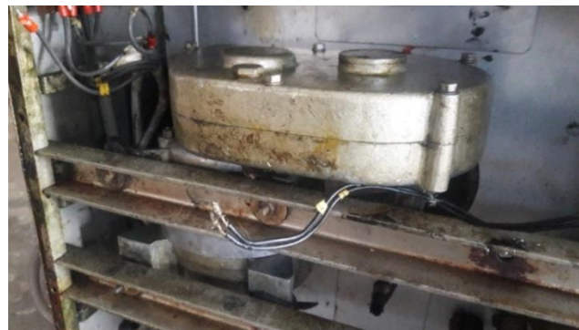
Figura 36. Estado de la parte mecánica (motor) antes de la reconstrucción
