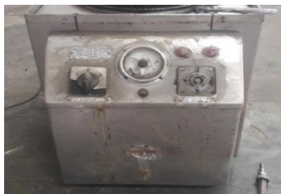
Figura 55. Gabinete de instalaciones eléctricas antes de la reconstrucción.
