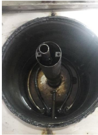
Figura 45. Tanque contenedor de la glicerina antes de la reconstrucción.
