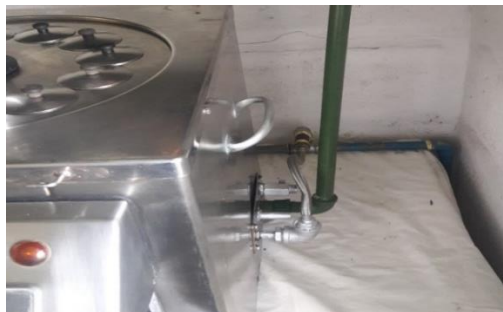
Figura 59. Entrada y salida de agua – glicerina después de la reconstrucción.
