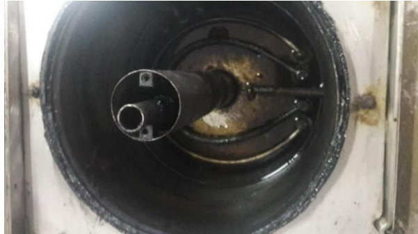
Figura 34. Estado de la vaina de mercurio antes del mantenimiento
