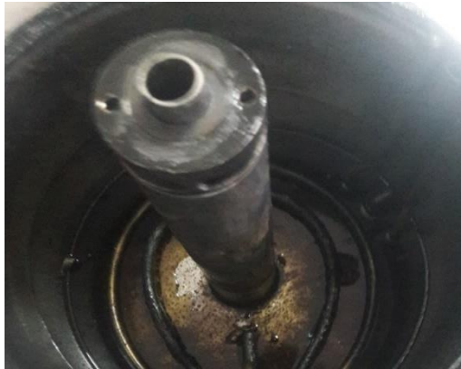
Figura 47. Eje central del equipo (vista interna) antes de la reconstrucción.
