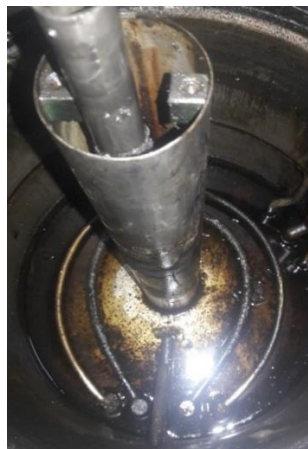
Figura 39. Estado de la parte mecánica (resistencias, eje central) antes de la reconstrucción
