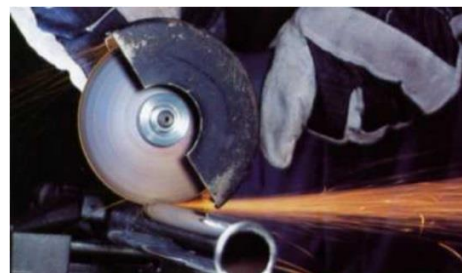
FIGURA 23: Corte manual de perfiles de acero
