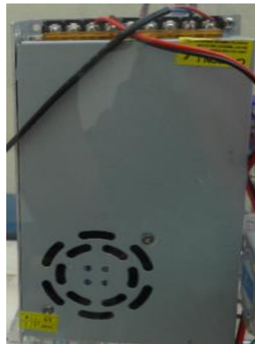
FIGURA 27: Instalación de la fuente de energía
