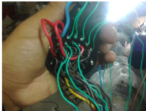
Figura 47 Ensamblaje de terminales para la comunicación entre PLC y las levas de trabajo
