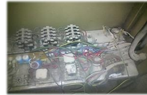
Figura 4 Control de mando marcha y paro de la máquina
