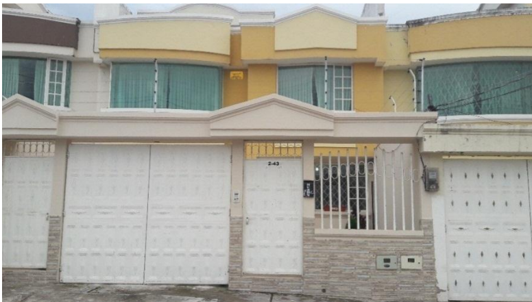
Figura 14 Instalaciones Shajana S.A. I
