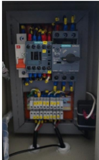
Figura 4.8 Gabinete metálico terminado.
