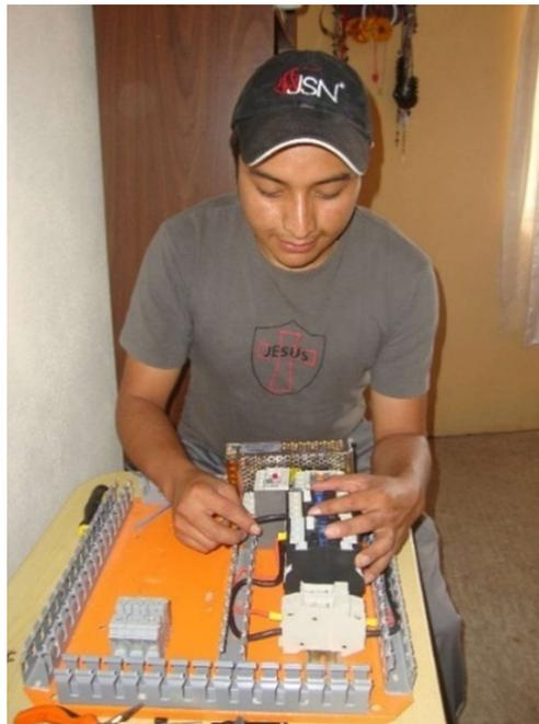
**Figura 4.8: Instalación de circuito para calentador**
