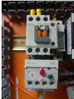
**Figura 4.7: Instalación de elementos de control para motor**
