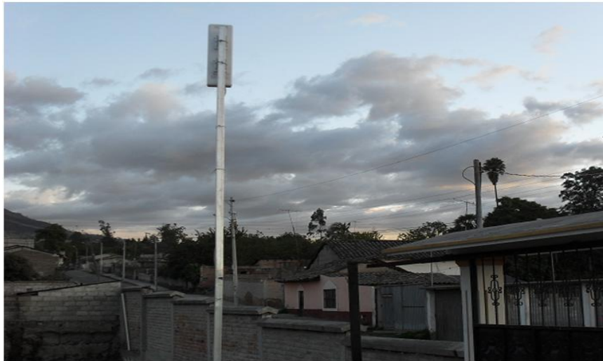
Figura 44. Concentrador Instalado en el Barrio Centro de San Antonio de Ibarra
