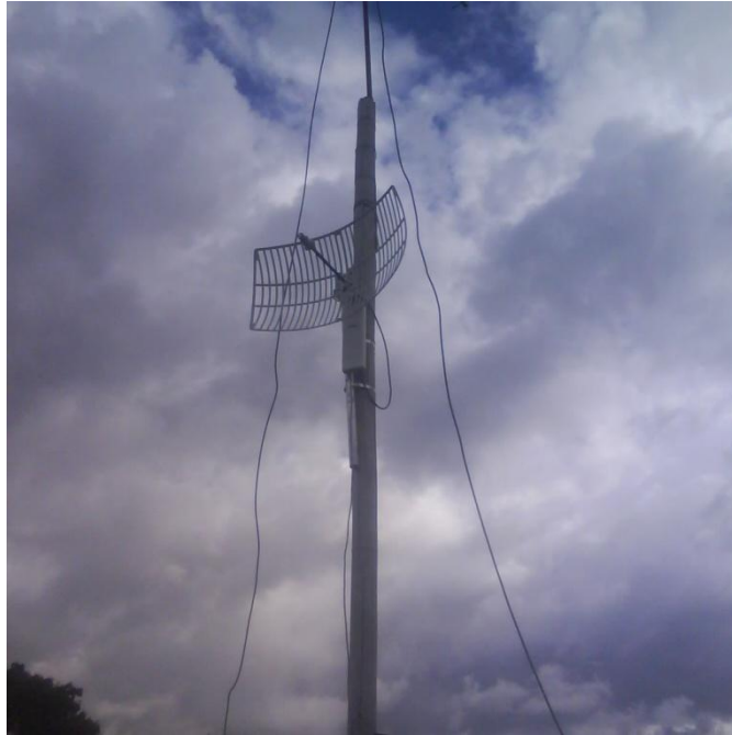
Figura 55. Instalación de equipos de radioenlace en San Antonio.
