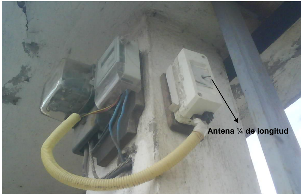
Figura 57. Ubicación del registrador 2 aproximadamente a 30m del concentrador. Nótese la antena de \frac{1}{4} de longitud de onda implementada en este registrador.
