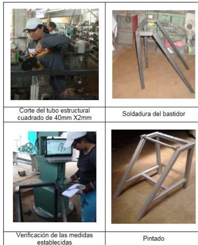
**Figura 3. 8: Construcción del bastidor**
