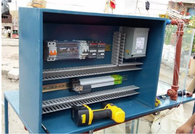
Figura 59 Montaje del tablero eléctrico de fuerza y control
