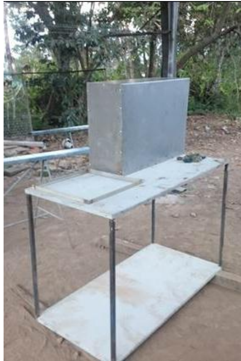
Figura 55 Elaboración de la parte mecánica del módulo didáctico
