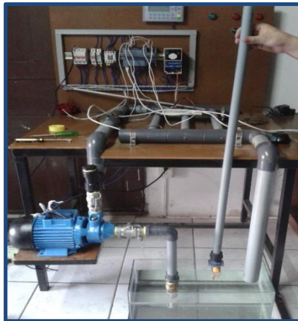
Figura N°. 48 Instalación de electroválvulas
