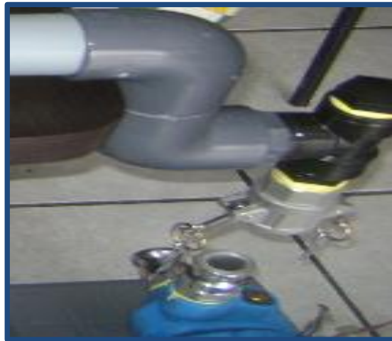
Figura N°. 38 Instalación de la bomba centrífuga
