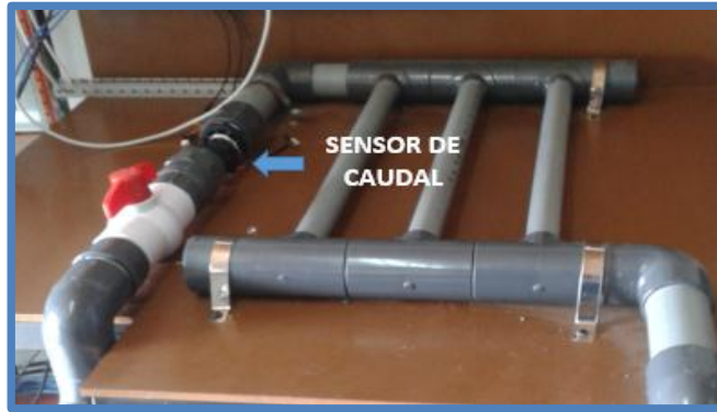
Figura N°. 47 Instalación del sensor de caudal
