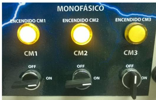
Figura 39. Encendido del segundo banco de condensadores
