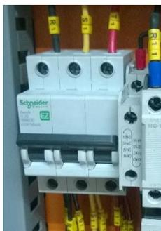
Figura 1. Breaker trifásico – motor trifásico
