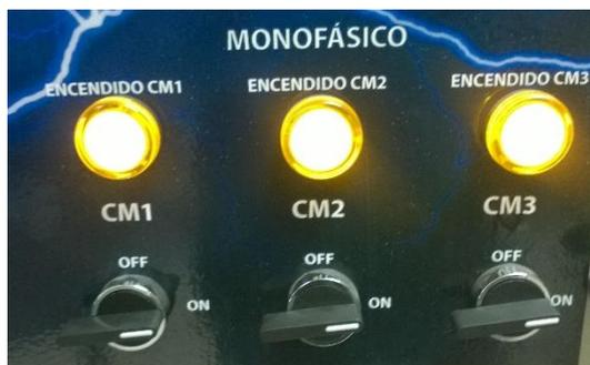
Figura 41. Encendido del tercer banco de condensadores
