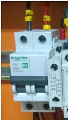
Figura 1. Breaker Bifásico – motor monofásico
