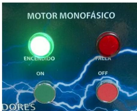
Figura 35. Pulsador de encendido y luz indicadora de motor monofásico
