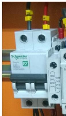
Figura 34. Breaker bifásico – motor monofásico
