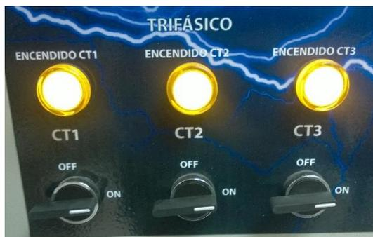
Figura 31. Encendido del tercer banco de condensadores
