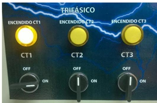
Figura 27. Encendido del primer banco de condensadores
