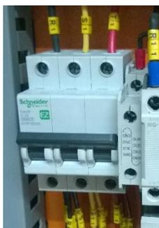
Figura 24. Breaker Trifásico – motor trifásico
