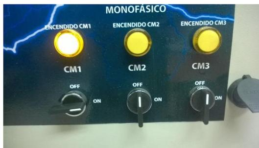
Figura 37. Encendido del primer banco de condensadores
