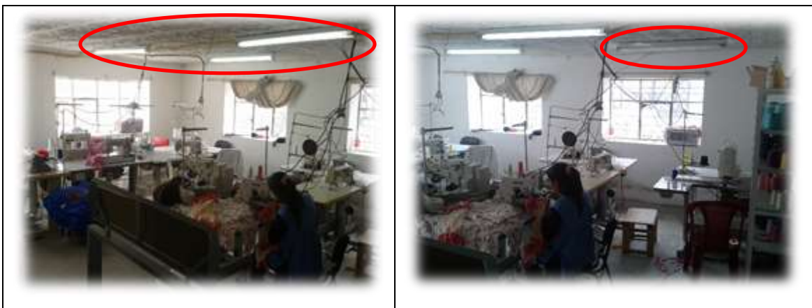
Fotografía 3: ILUMINACIÓN EN MAL ESTADO E INADECUADA
