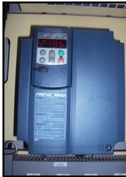
Figura N° 39: Variador de frecuencia que controla la velocidad
