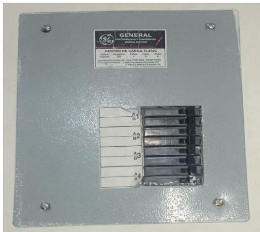
*Figura 25 Tablero de distribución de los circuitos eléctricos*
