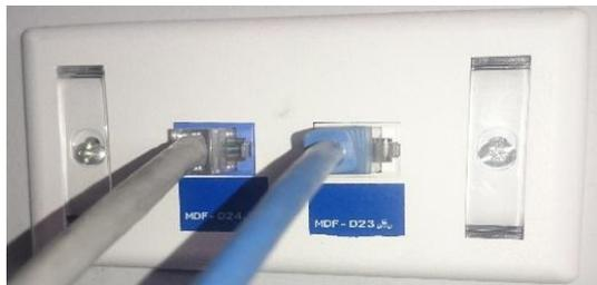
**Figura 29 Puntos de red del sistema de cableado estructurado**
