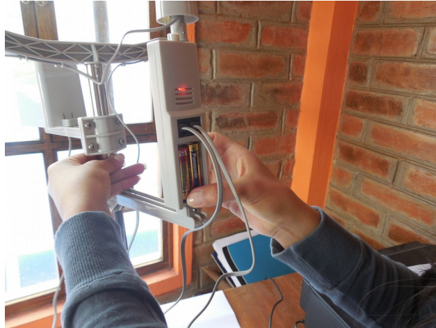
FIGURA 2.10: Colocar baterías al termohigrómetro
