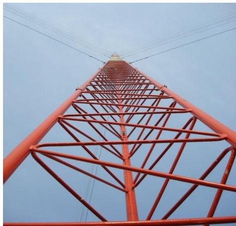
Figura 55. Torre empleada para antenas de transmisión FM
