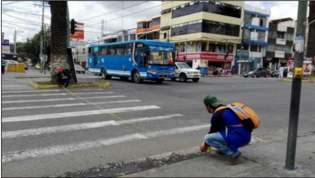
Figura 3-3: Foto medición ancho de la calzada
