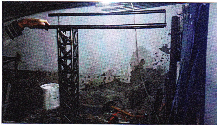
Figura 132: Torre y brazo de la pluma grúa (vista lateral.)
