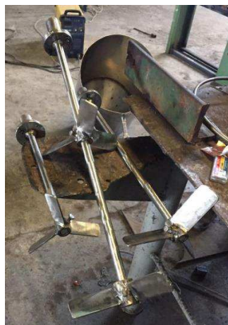
Figura 3.23. Construcción de los impulsores.
