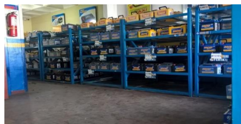
Figura 2. Almacenaje de baterías plomo ácido.
