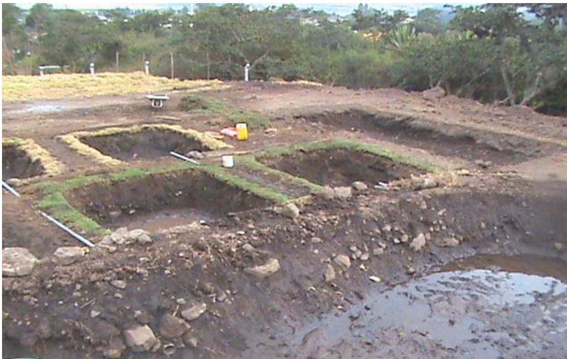
Fotografía 2.- Adecuación de piscinas
