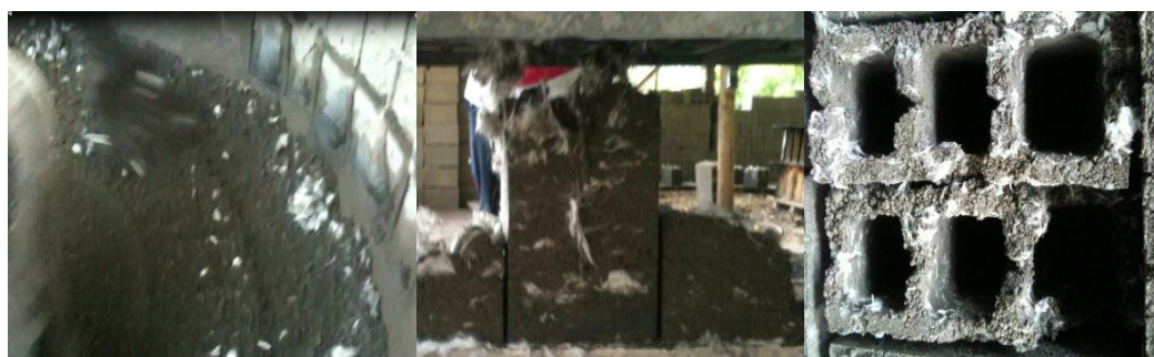
FOTOGRAFÍA 3: Problemas generados durante la fabricación de bloques con Acrílico.
